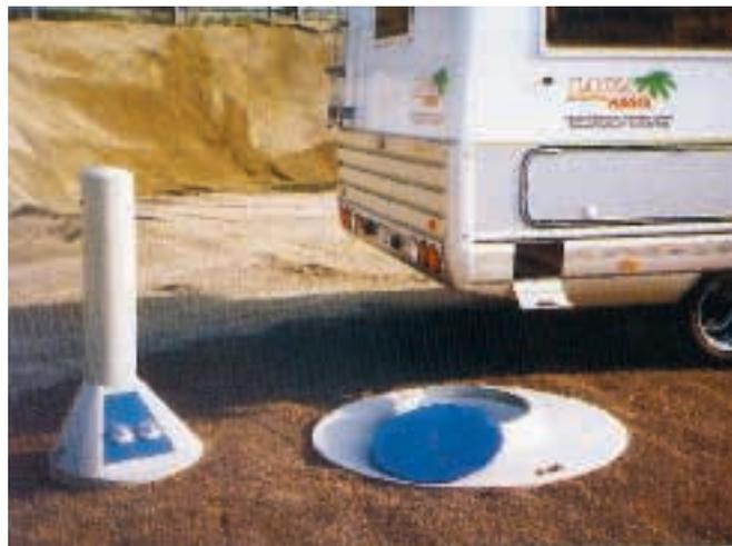
**COME FUNZIONA:** il pozzetto potrà ricevere le acque nere e chiare dei serbatoi di recupero. Dopo lo scarico delle acque si azionerà la pedaliera temporizzata per la completa pulizia del pozzetto interno. La colonnina è inoltre provvista di un rubinetto per il rifornimento dell'acqua
