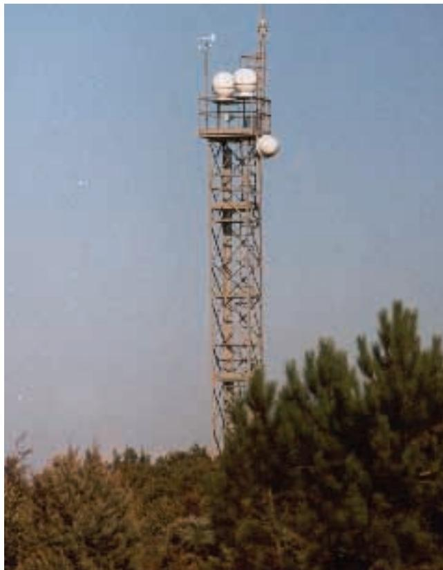
*A destra un sistema di lotta attiva agli incendi, a vantaggio sia della centrale che del bosco, questa torre possiede dei sensori in grado di rilevare anche piccolissimi fuochi nel raggio di 10 Km.*
