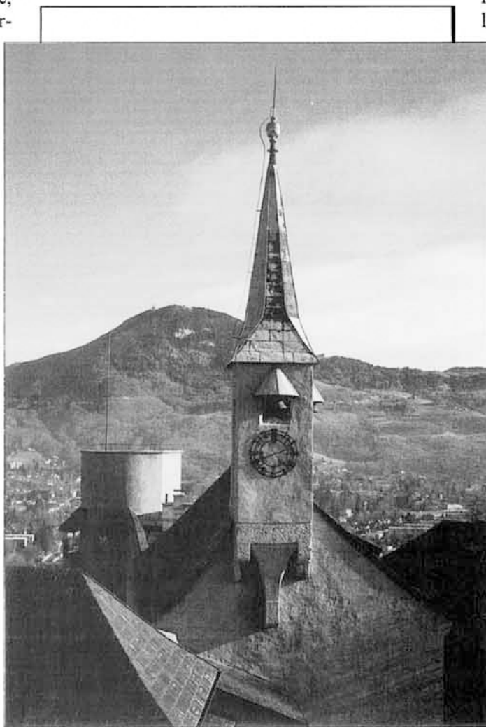
Salisburgo: Hohensalzburg (fortezza medioevale - particolare)
