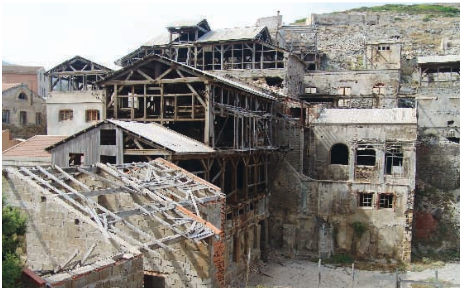
Gli impianti della vecchia miniera all'Argentiera
