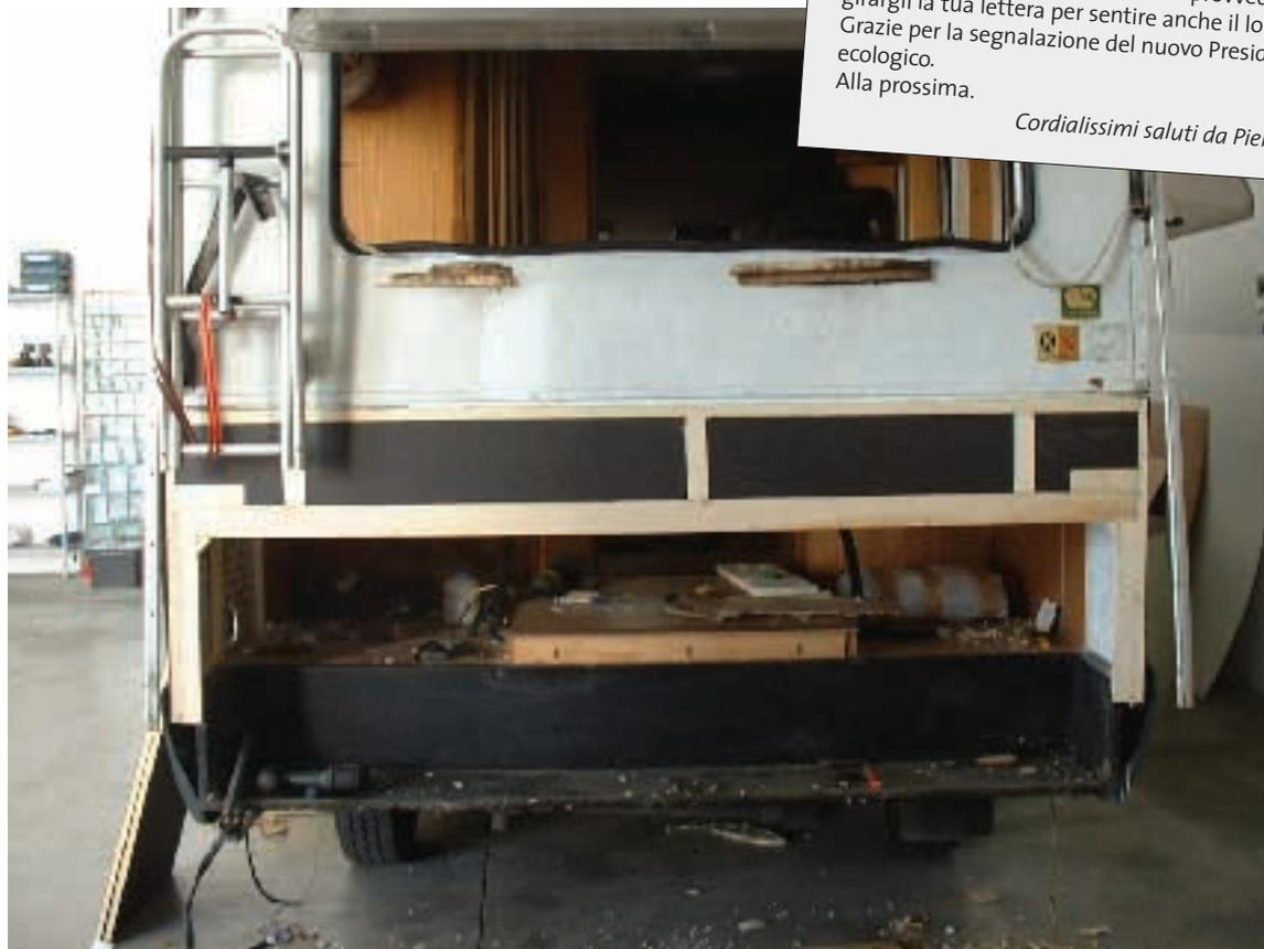
Veicolo in riparazione per una infiltrazione nata tra la giunzione della lamiera posteriore
