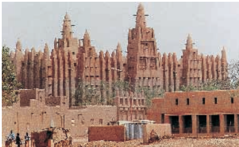
Moschea di Mopti, nel Mali. Architettura di terra cruda, accanto ad abitazioni dello stesso materiale. Per la loro conservazione, basta una buona manutenzione.
