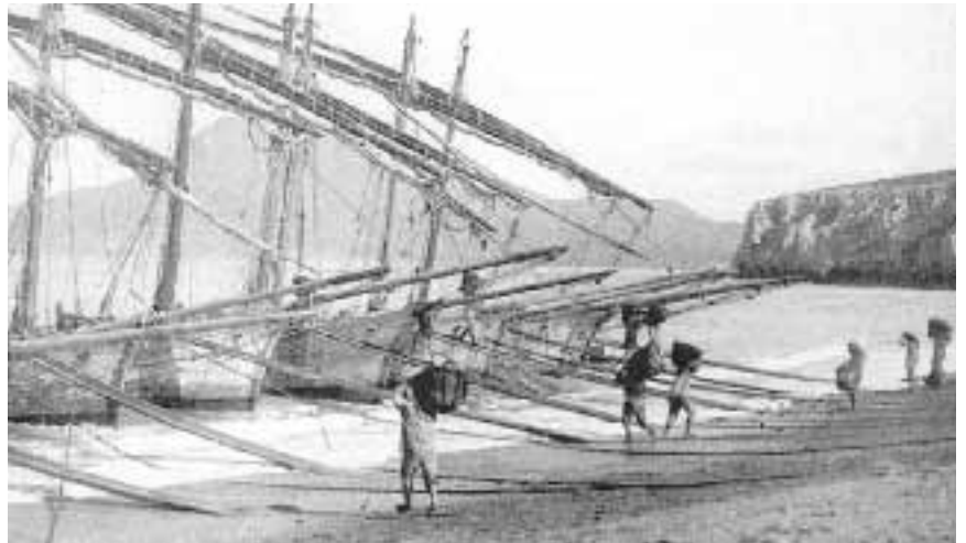
A sinistra: una foto del 1930 riprende la fase di scarico dei silos il materiale tramite il nastro trasportatore finiva direttamente nella stiva del piroscafo (Foto Igea). Sopra: carico a mano delle bilancelle ormeggiate sulla spiaggia di Buggerru. Gli operai trasportavano il minerale a spalla tramite delle coffe (foto Igea).
