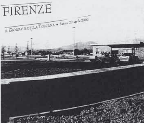
Si è aperta ieri una delle opere fiorentine più importanti realizzate con i fondi del Giubileo. Ma i lavori non sono ancora finiti
