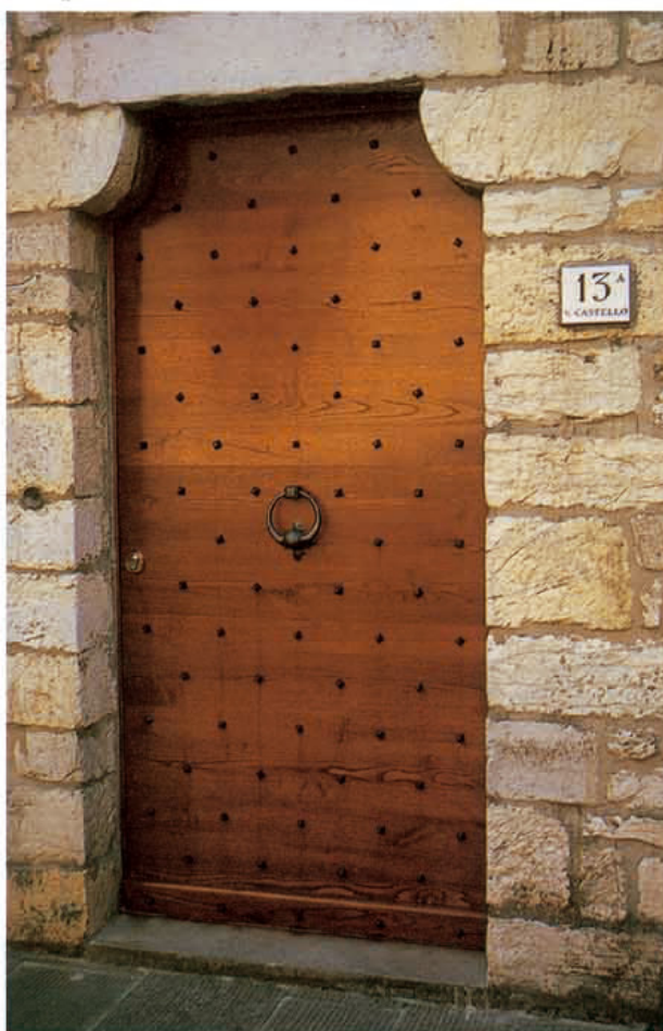
una pannellatura esterna
