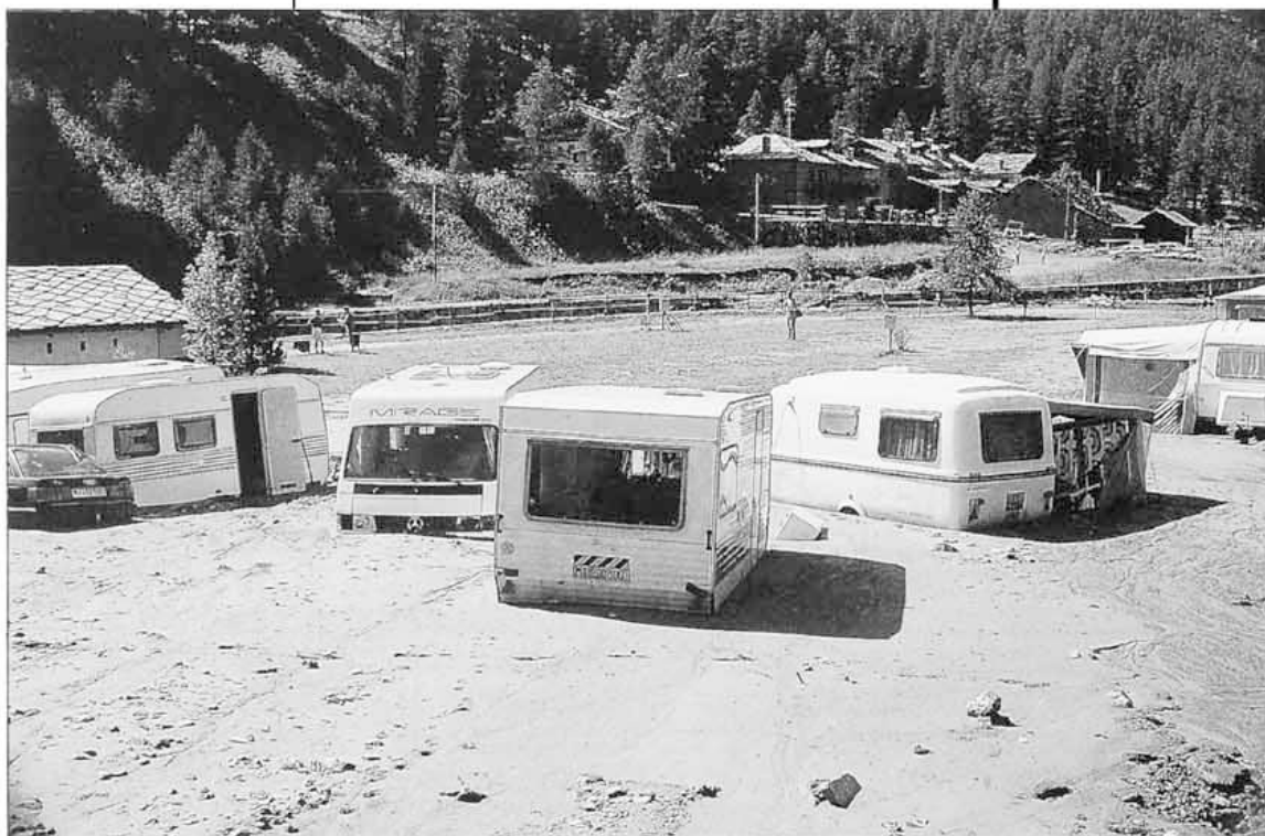
Visione parziale del campeggio dopo la frana
