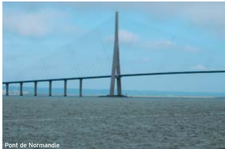
Pont de Normandie
