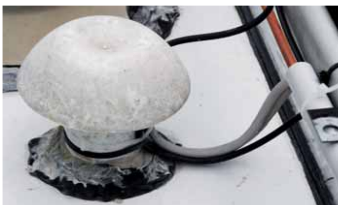
Il passaggio dei cavi all'interno attraverso il tubo della cappa aspirante
