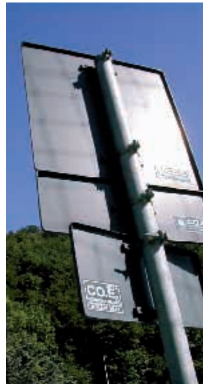
Segnaletica in violazione di legge
